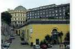
PalaBarbuto. L'indagine della Procura di Napoli ha disposto la chiusura dell'impianto non a norma.
