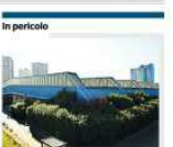
PalaBarbuto. L'indagine della Procura di Napoli ha disposto la chiusura dell'impianto non a norma.
