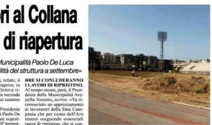
«Proseguono i lavori di ristrutturazione all'impianto del Vomero»
