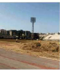
Proseguono i lavori di ristrutturazione all'impianto del Vomero
