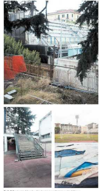
Stadio Collana. Lo stato di degrado e abbandono in cui versa l'impianto sportivo del Vomero
