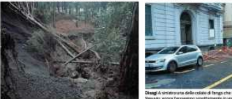
Da oggi, i lavori sulla costa di Napoli che erano stati sospesi. In basso, dopo l'ennesimo cedimento in via Crispi, il traffico è bloccato
