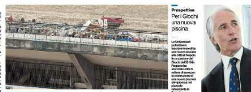
La foto mostra il cantiere di collana, dove si sta lavorando per la messa in sicurezza dell'impianto. In alto a destra, un ritratto di Giovanni Malagò.
